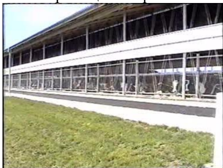
Рис. 95. Система вентиляційних штор
