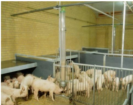
Рис. 132. Пневматичні системи транспортування кормів
