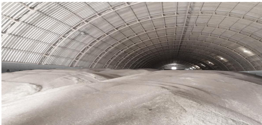
Рисунок 5.6 – Зерносховище з завантажувальним зерновим матеріалом у піддонах з бортами під час охолодження у ТОВ «СПП ЛАНА»
