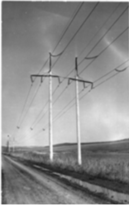
Рис. 9. Первая в мире управляемая двухцепная самокомпенсирующаяся высоковольтная линия электропередачи 110 кВ (СВЛ-110 кВ).
