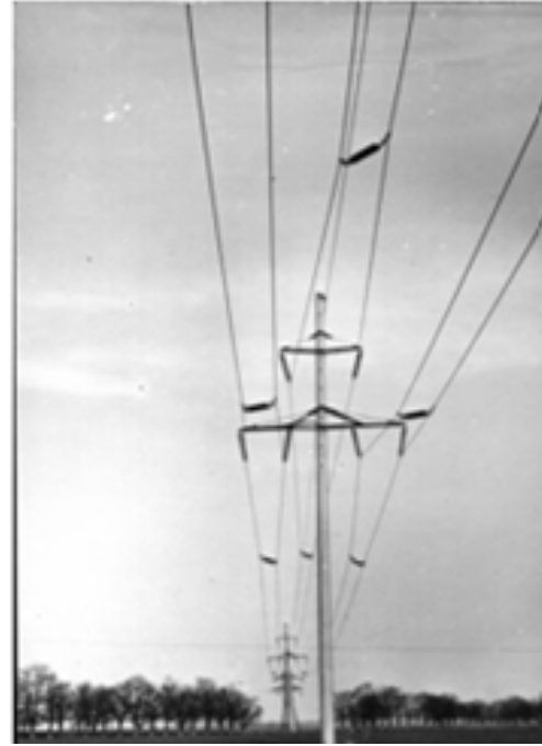
Рис. 9. Первая в мире управляемая двухцепная самокомпенсирующаяся высоковольтная линия электропередачи 110 кВ (СВЛ-110 кВ).
