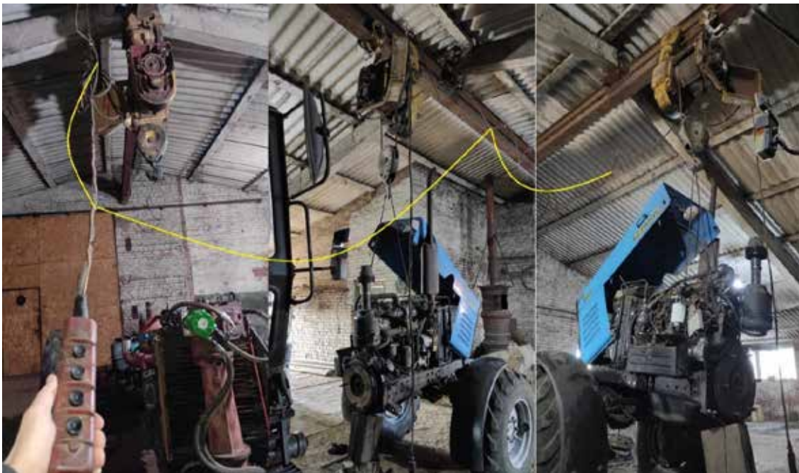
Рис. 2. Виконання проводки тельфера гнучким багатожильним кабелем
