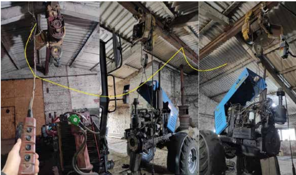
Рис. 2. Виконання проводки тельфера гнучким багатожильним кабелем
