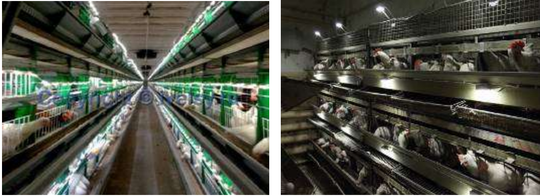
Рисунок 5 –Светильники расположены над кормовым желобом
