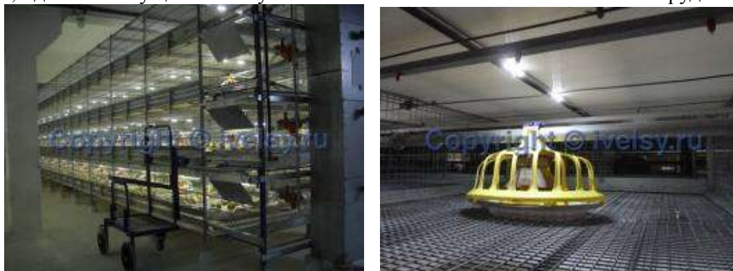
Рисунок 4 – Светильники расположены внутри клеток над кормушками
