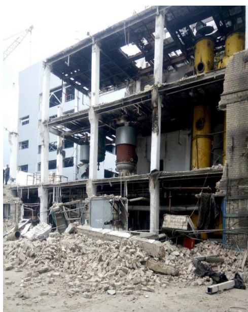
Рис. 1. Демонтаж існуючого технологічного комплексу
