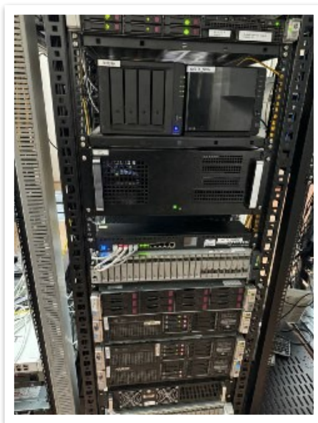
Рис. 1. Геодезичний навчальний сервер в стійці дата-центру
