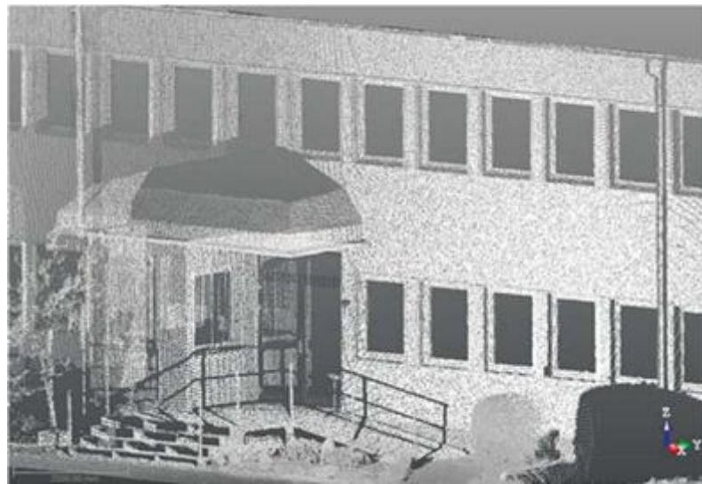
Рис. 3.2 – Зображення будівлі НДГТКІ, отримане із хмари точок під час лазерного сканування [25]
