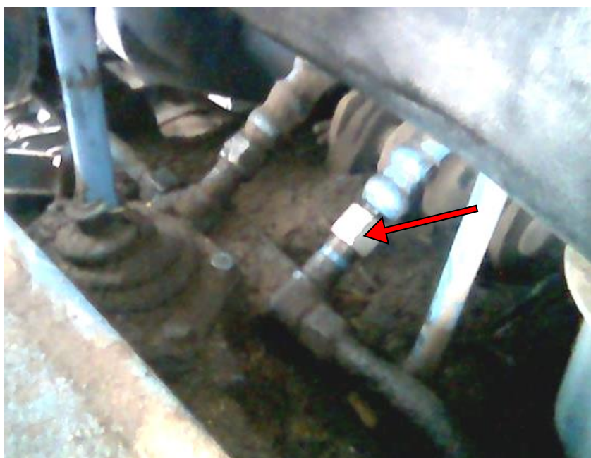
Рис. 3.17. Місце встановлення дросельних втулок до магістралі основного гідроциліндра через люк в полу кабіни енергетичного модуля МЕЗ.
