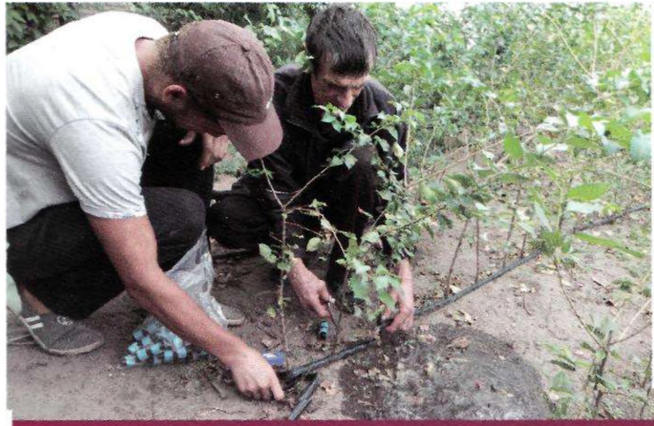
Ремонт труб системи краплинного зрошення
