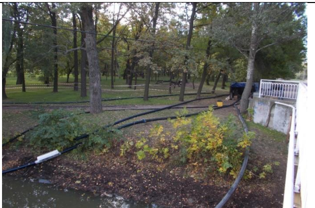
Фото 4. трубопроводи для пумпи
