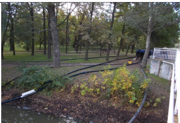
Фото 4. трубопроводи для пумпи
