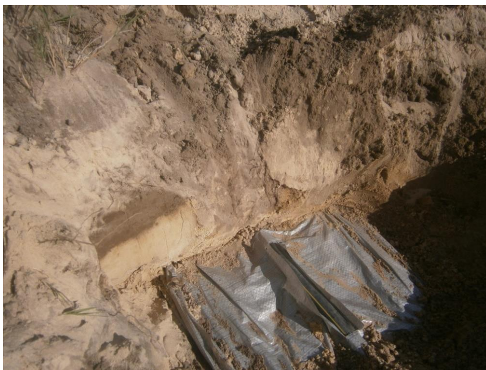
Рис. 4.3 Общий вид уложенной трубы оросителя с противофильтрационным экраном
