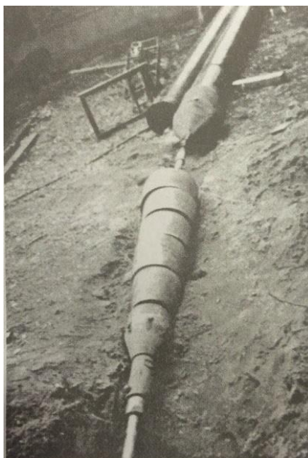
Рис. 1.1 Раскатчик скважин РТ-470 с закрепленной в хвостовой части трубной плетью для протаскивания в горизонтальную скважину
