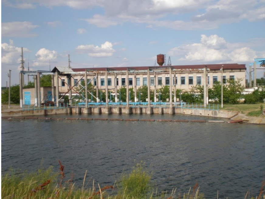
Рис. 2.7. Загальний вигляд приміщення насосної станції Західного групового водопроводу
