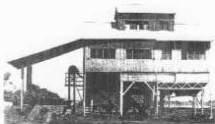
Зерноочисний агрегат продуктивністю 25 т/год у НДІ "Лугань" Мелітопольського району Запорізької області
