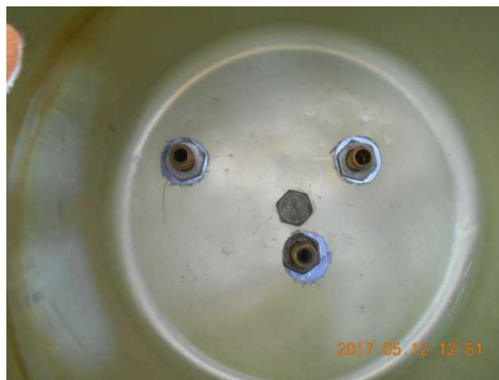
Рис. 5. Штуцери для приєднання відвідних шлангів
