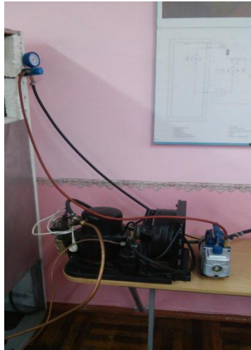
Рис. 6. Фотографія загального вигляду лабораторної установки для вакуумування парової компресійної холодильної машини
