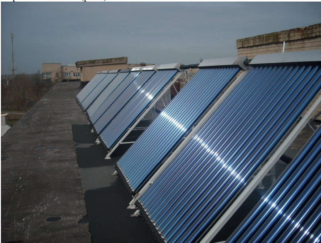
Рисунок 1 - Сонячні вакуумні колектори на даху бюджетної установи міста
