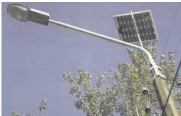
Рисунок 1 - Фотоелектричні перетворювачі для освітлення дороги.
