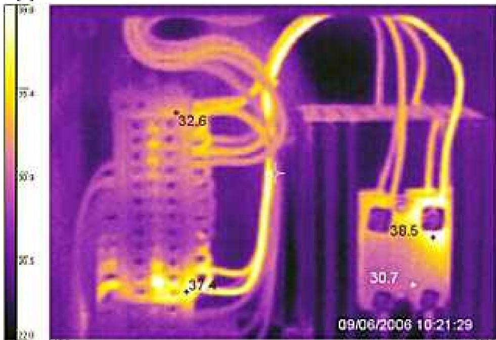
Рисунок 1 - Снимок перегрева кабелей и ненадежного соединения
