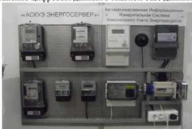
Рисунок 1 - Общий вид расположения электронных счетчиков системы АСКУЭ
