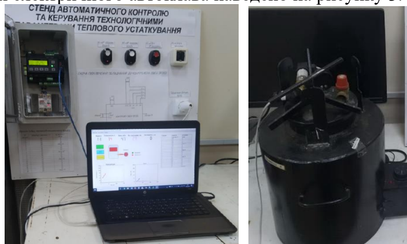
Рис. 3. Загальний вид стенда автоматизації електричного автоклава
