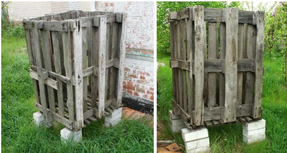
Рис. 2. Варіант конструкції корпусу ящика для збирання дощової води
