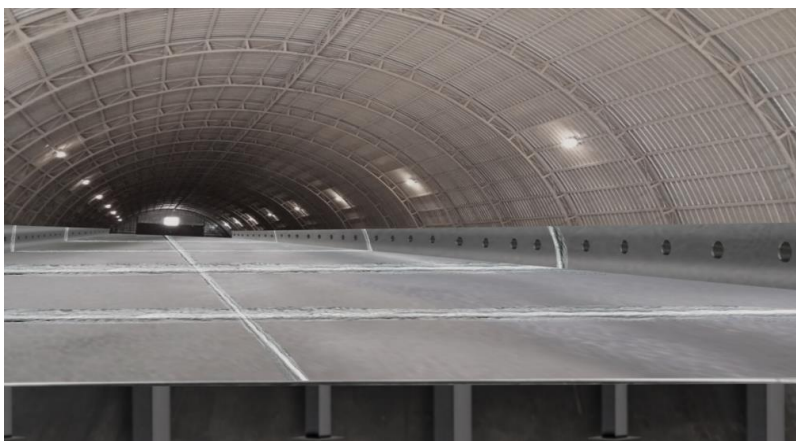
Рисунок 43 – Розташування металевих піддонів з бортами відносно бетонної підлоги зерносховища
