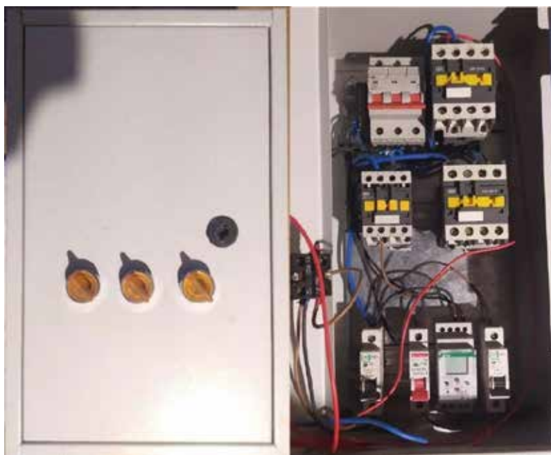
Рис. 1. Щит керування вентиляційною установкою
