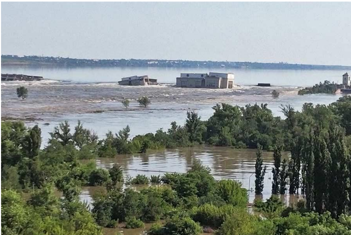
Мал. 3. Вигляд зруйнованої греблі Каховської ГЕС
