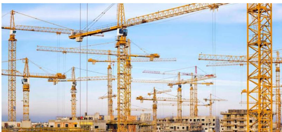
Баштові крани Liebherr (Німецька машинобудівна компанія)
