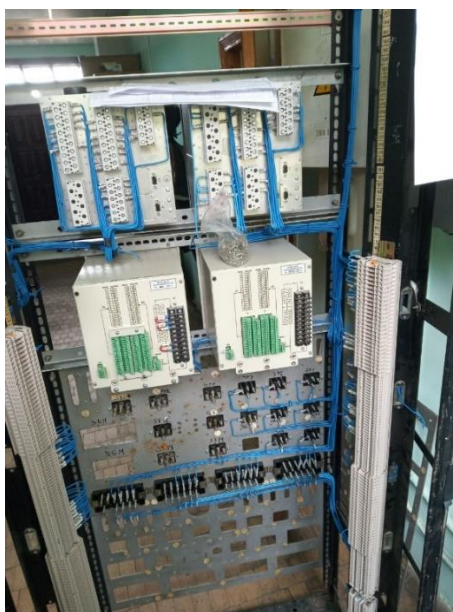
Рис. 4. Панель захисту силового трансформатора для підстанції 110/35/10 на основі SIEMENS SIPROTEC та РЕЛСІС
