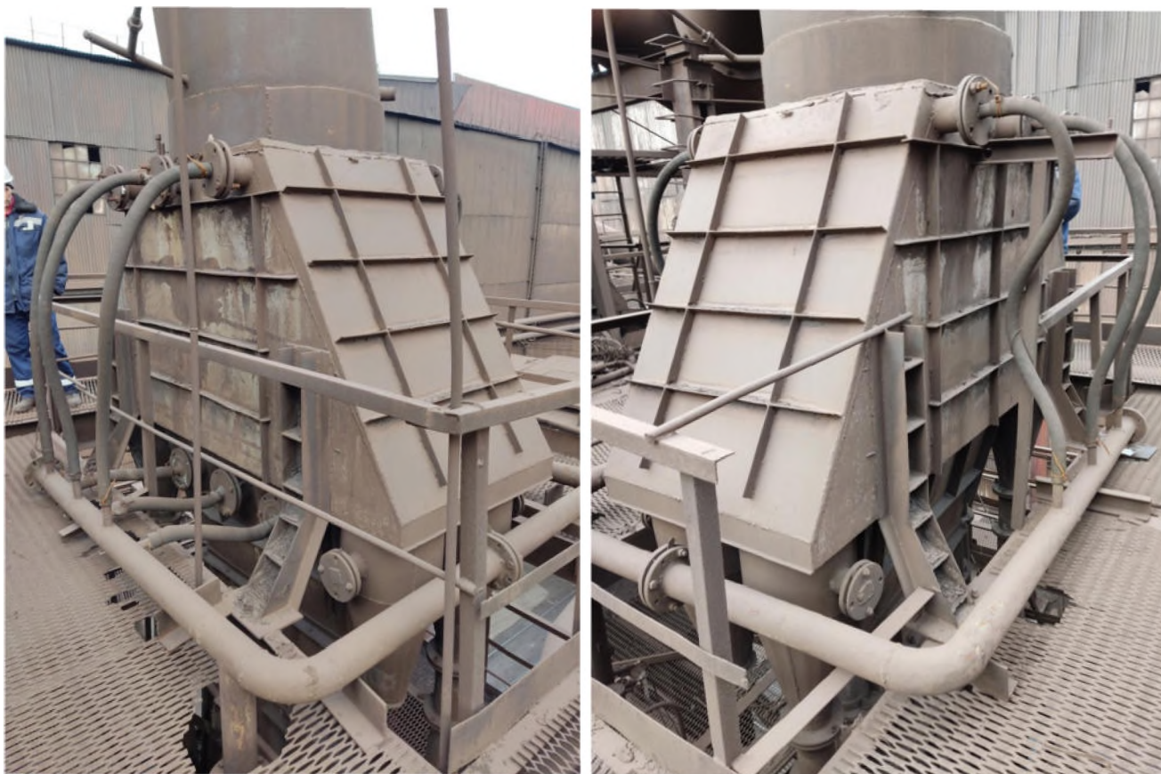
Загальний вигляд камери розпилу мокрого газоочищення
