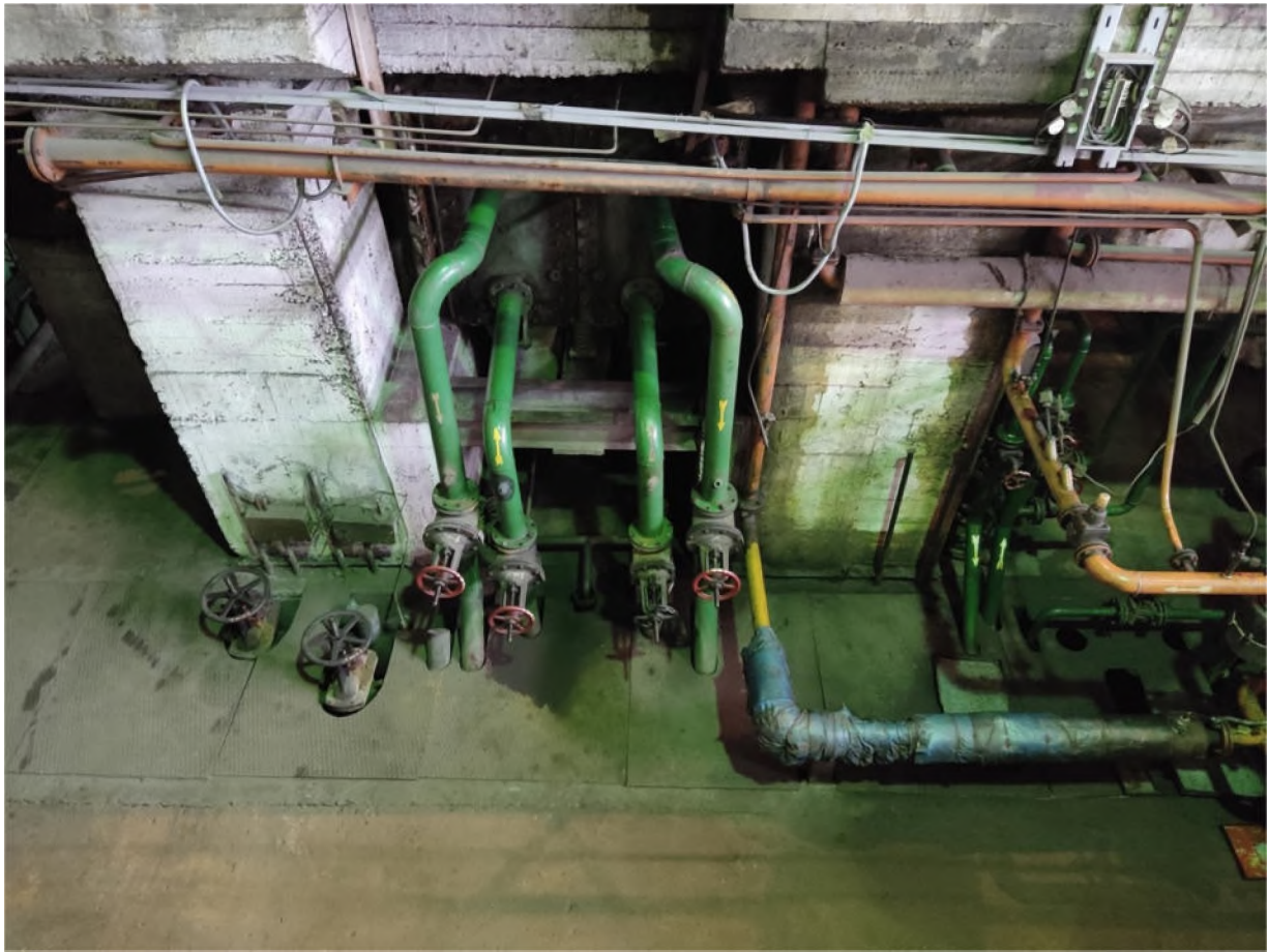
Система комунікацій водоохолодження турбіни (вид зверху)
