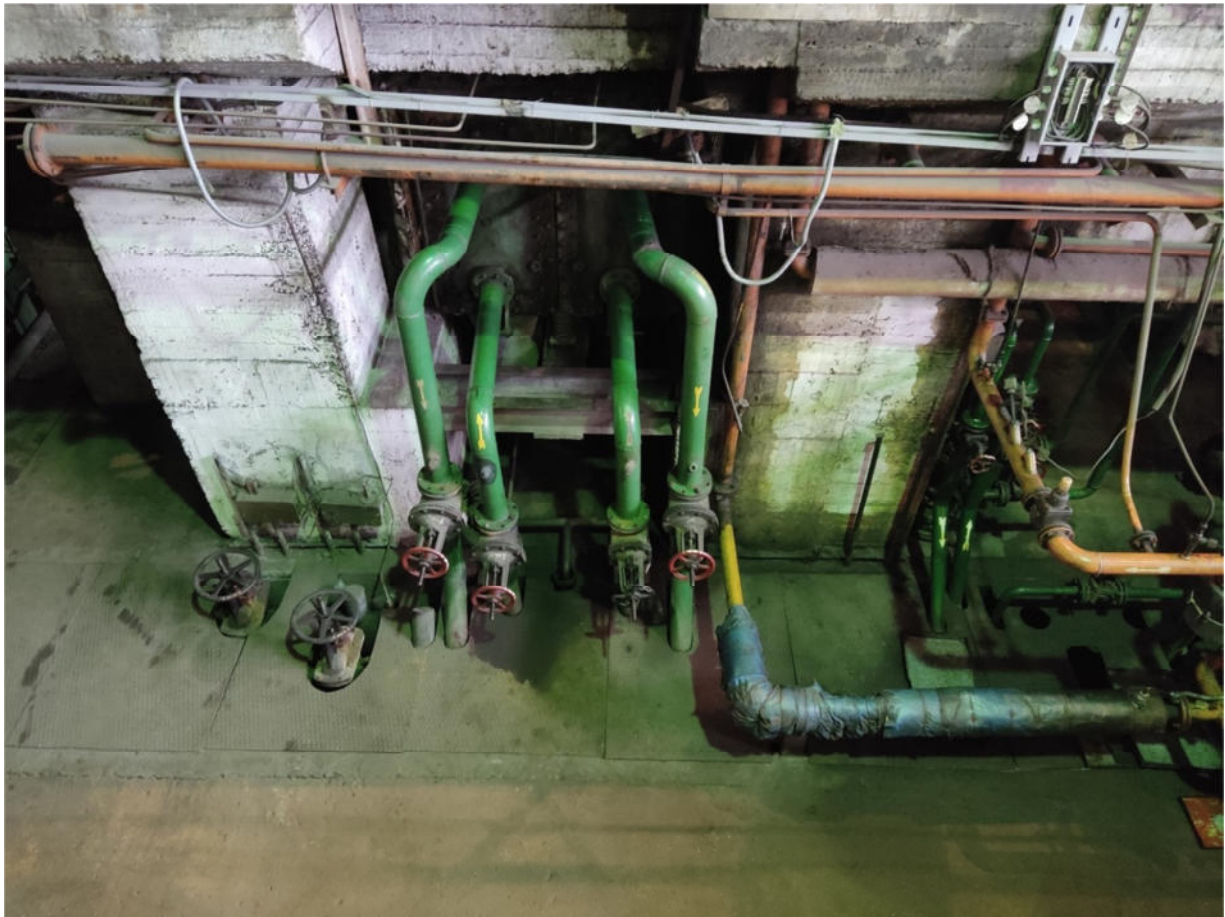
Система комунікацій водоохолодження турбіни (вид зверху)
