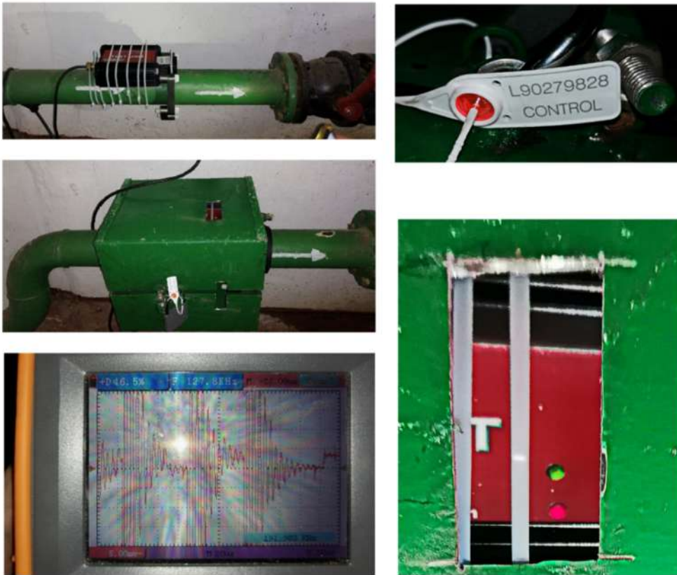
Рис. 2. Загальний вигляд (Фото) контрольних елементів в процесі монтажу і запуску приладу «HydroFLOW»
