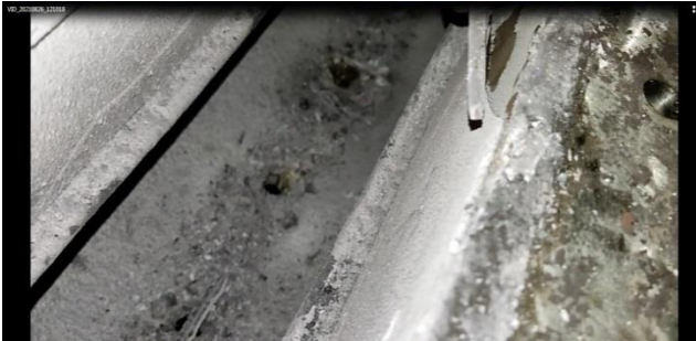
Зняття відкладення з бокової вертикальної стінки
