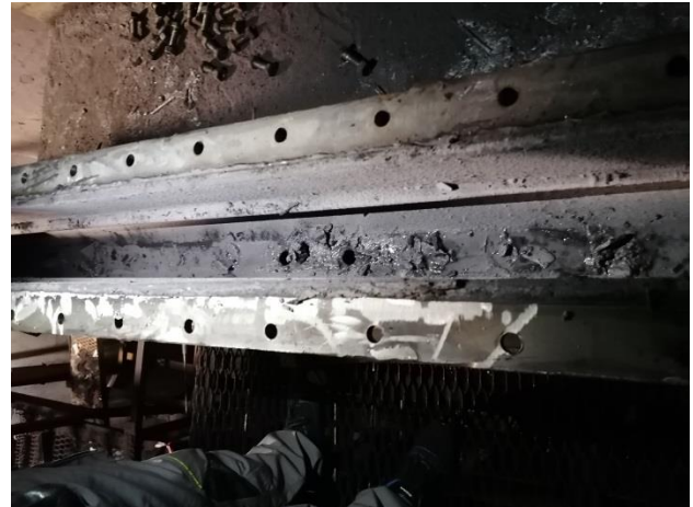
Загальний вигляд внутрішньої поверхні
