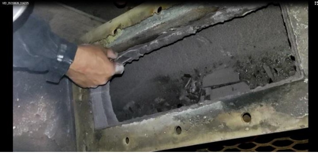
Зняття відкладення з бокової вертикальної стінки оглядового вікна
