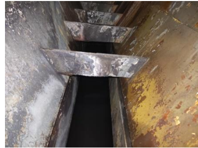
Загальний вигляд нижньої частини бака
