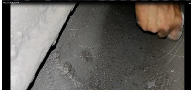
Відкладення на внутрішній поверхні трубопроводу незначні та дуже тверді. Немає можливості виміру товщини відкладень
