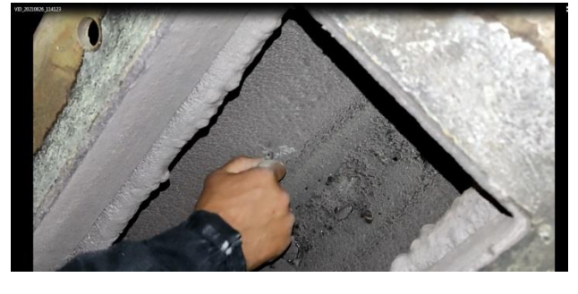
Відкладення на внутрішній поверхні трубопроводу незначні та дуже тверді. Немає можливості виміру
