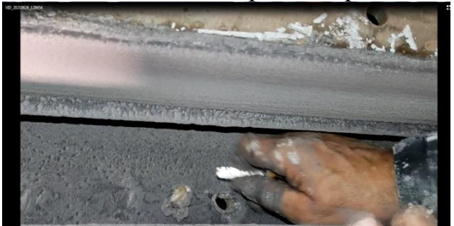
Сторонній предмет, що закупорив отвір
