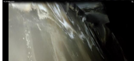
Бокові стінки баку мають сліди іржі та не мають вапняних або карбонатних відкладень
