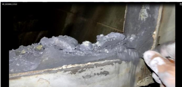
Оглядове вікно баку. Присутні відкладення на рамці оглядового вікна (мертва зона)
