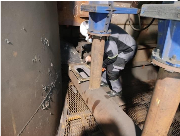
Огляд внутрішнього стану трубопроводу через оглядове вікно
