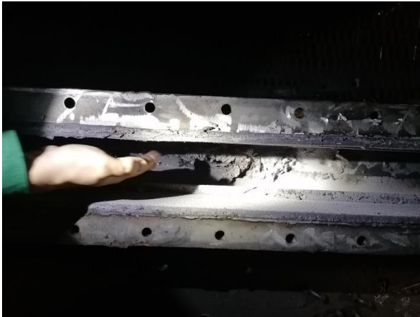
Загальний вигляд внутрішньої поверхні
