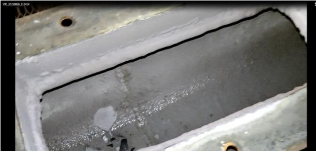
Загальний вигляд внутрішнього стану іншої гілки трубопроводу
