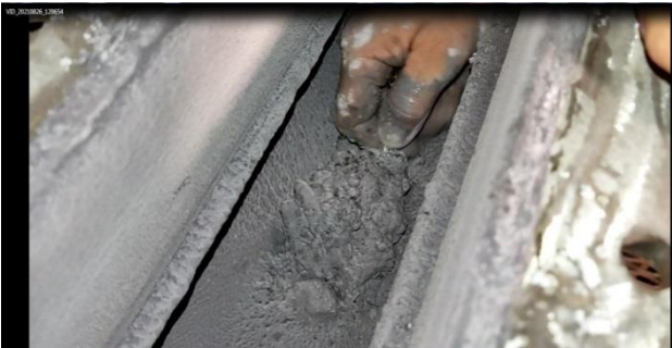
Видалення щєбня з отвору на трубку розпилу
