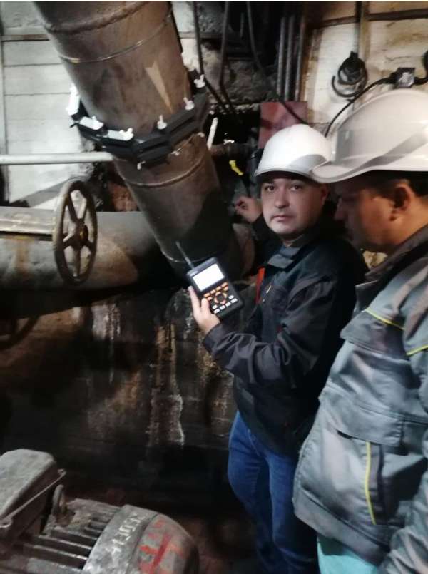
Перевірка сигналу на трубопроводі після приладу HydroFLOW. Сигнал стабільний
