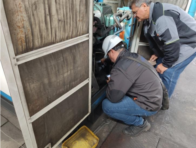
Перевірка сигналу на водяному контурі охолодження компресора № 2 ВВ-50 Теплообмінник пластинчатий Термекс. Сигнал стабільний
