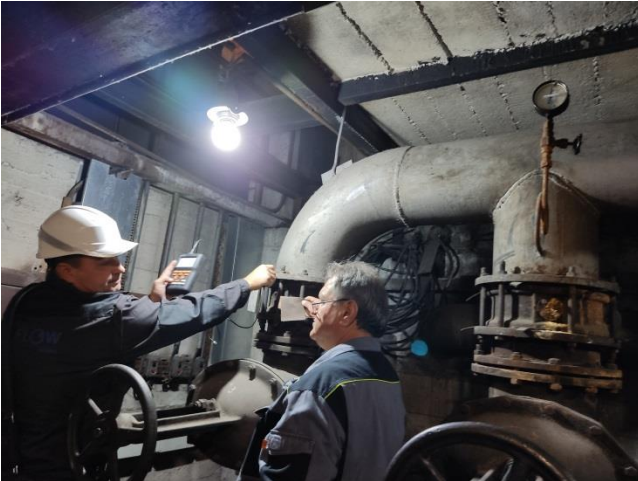
Перевірка сигналу на трубопроводі до приладу HydroFLOW після основного насосу. Сигнал стабільний
