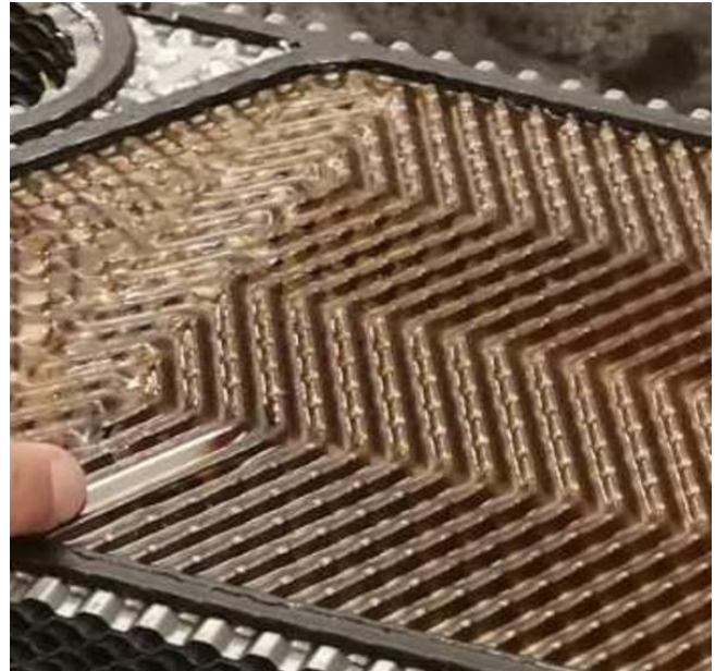
Рис. 2. Стан пластини із застосуванням приладу підготовки води
