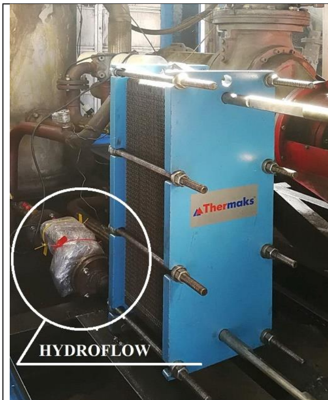
Рис. 3. Звгальний вигляд і місце розташування приладу «Hydroflow Industrial (test)»,
