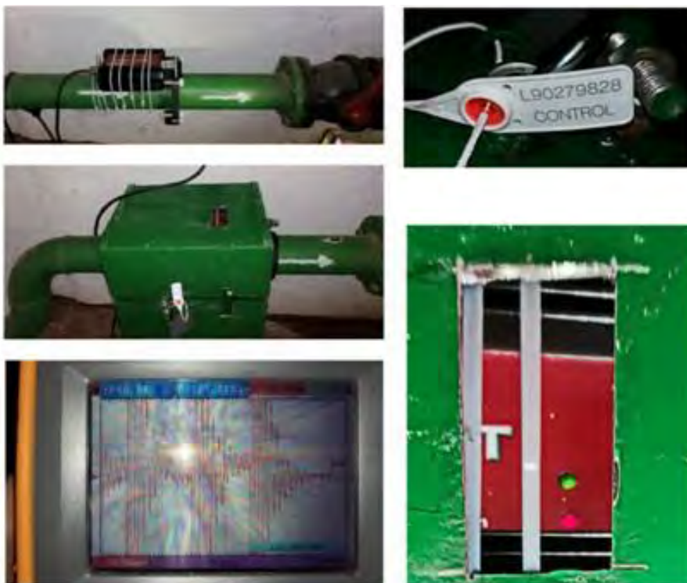
Рис. Загальний вигляд (фото) контрольних елементів в процесі монтажу і запуску приладу «HydroFLOW»
