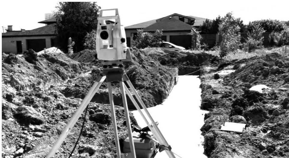
Рис. 1. Перевірка точності земляних робіт для будівництва фундаменту
