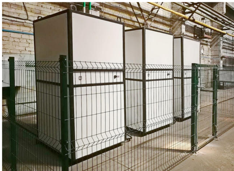
Мал.3. Група електробойлерів потужністю по 60 кВА
