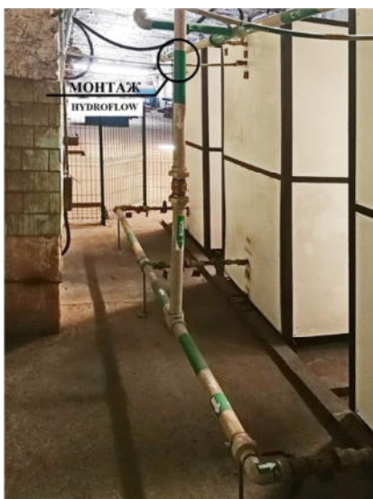
Мал.6. Місце монтажу приладу «HYDROFLOW» на групу електробойлерів
