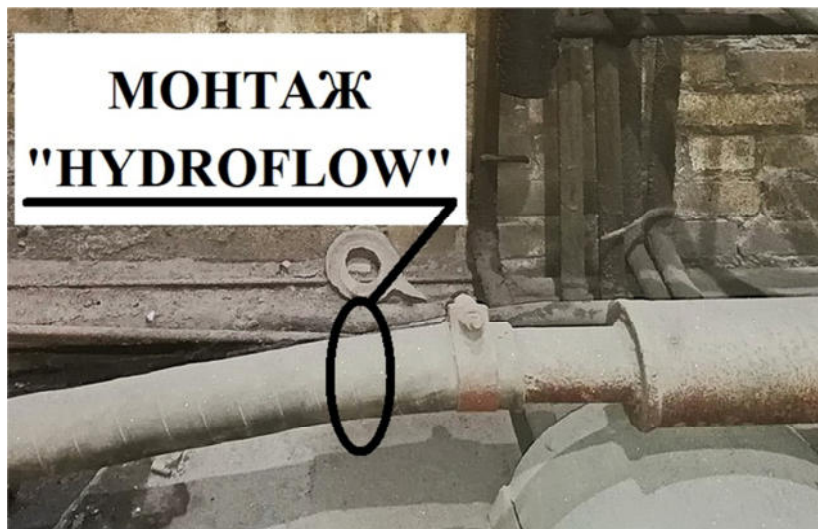
Мал.5. Місце монтажу приладу «Hydroflow» на електронечі
