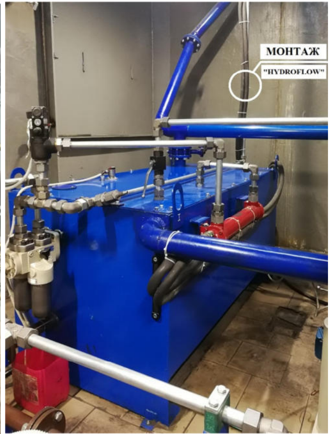
Мал.6. Місце монтажу приладу «HydroFLOW AQUAKLEAR»P(C)45 на кулері SA
