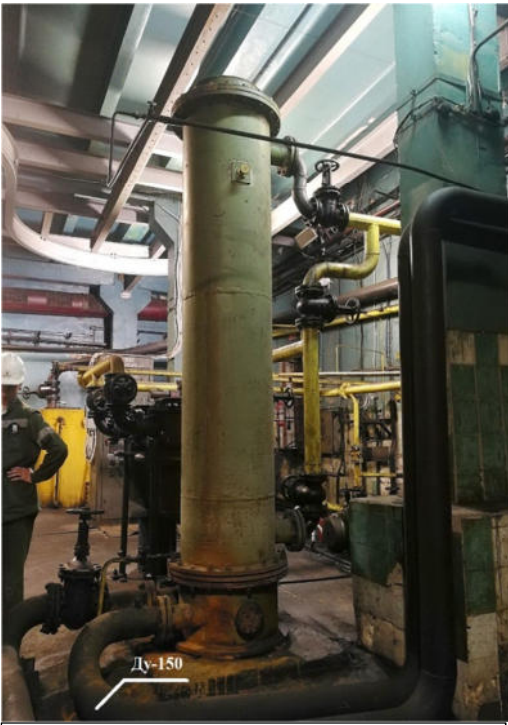
Мал.2. Зовнішній вигляд маслоохолоджувача
