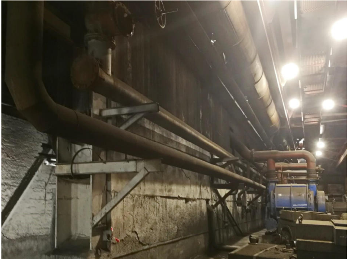
Мал.4. Труба подачі води на вакуумні насоси
