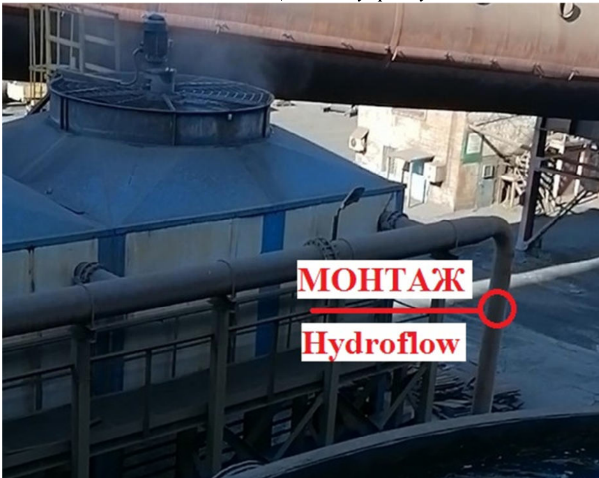
Мал. 9. Місце монтажу приладу
