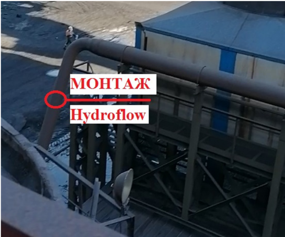
Мал. 8. Місце монтажу приладу
