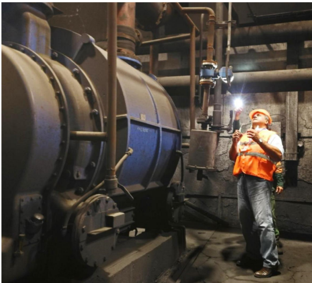
Мал.3. Обв'язка вакуумного насосу трубами меншого діаметру
