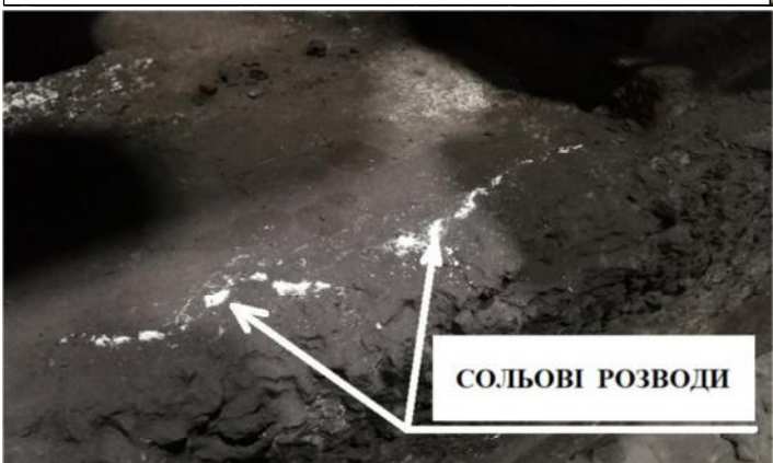
Мал.7. Сольові розводи на поверхні фундаменту насосу
