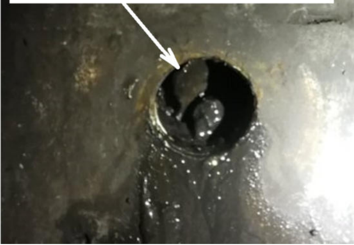
Мал.5. Відкладення у отворі корпусу насосу
