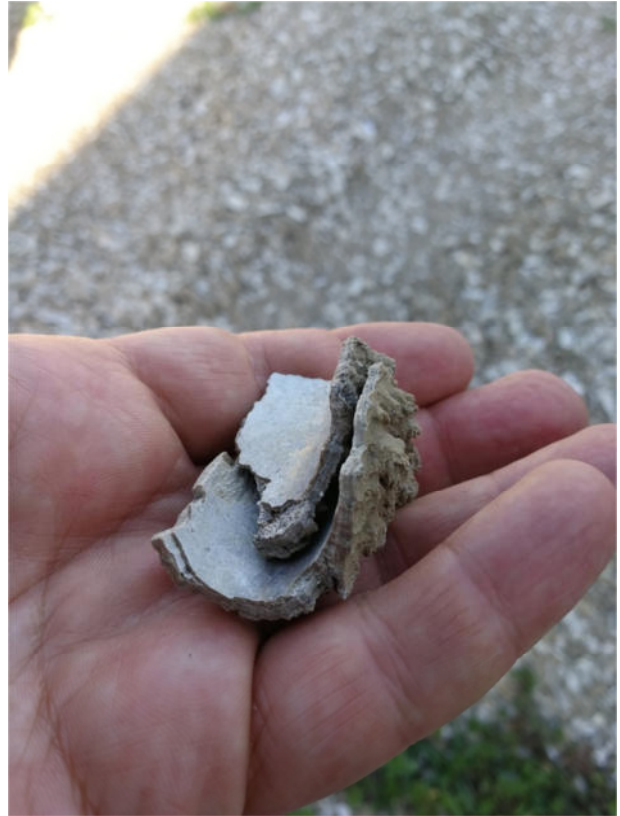
Мал. 8. Відкладення з трубок охолодження тосолю
