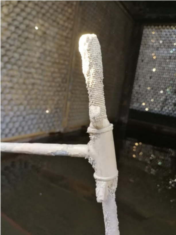
Мал. 7. Відкладення на трубопроводах
