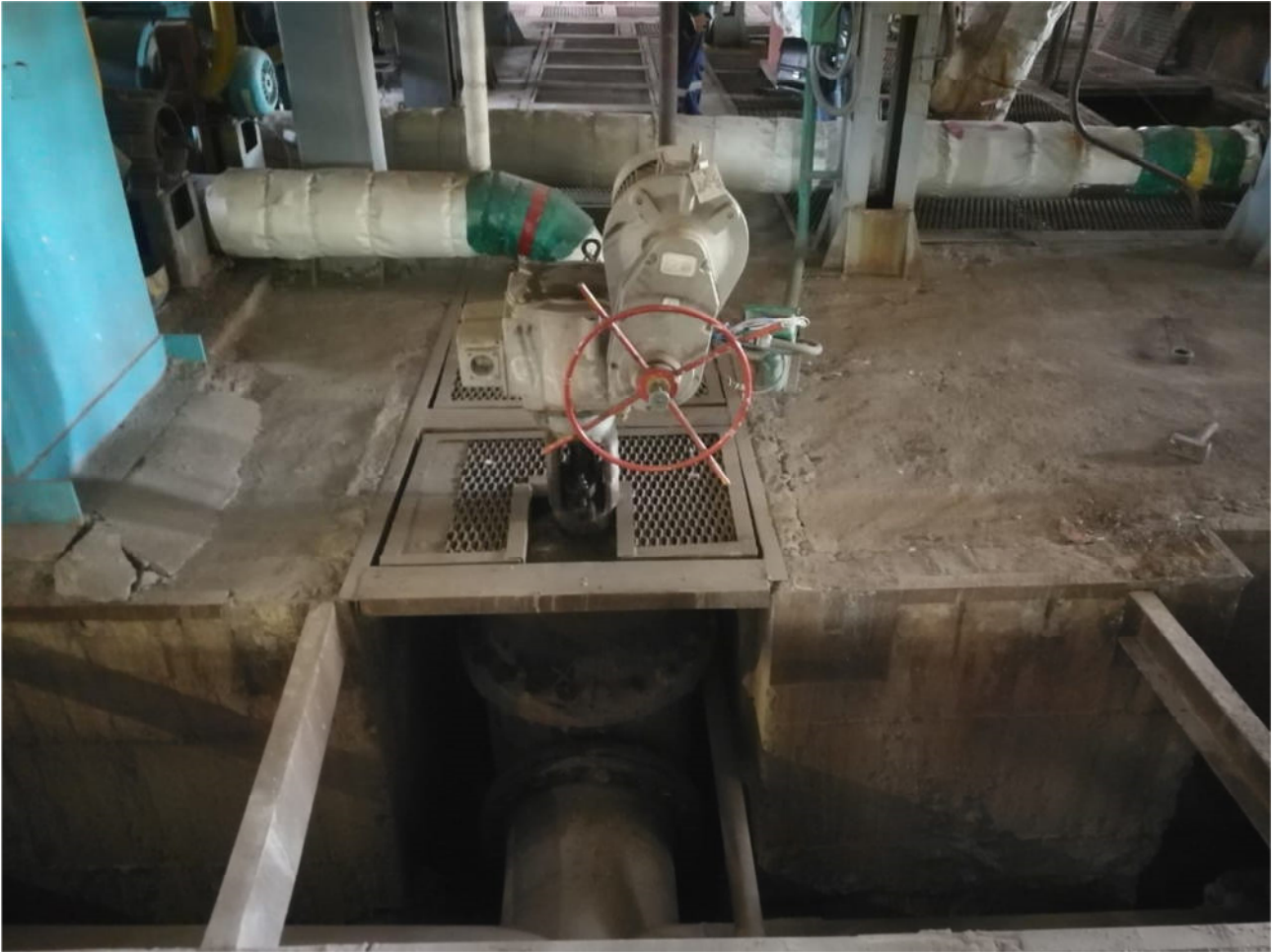
Мал. 4. Засувка Ø 500 мм
