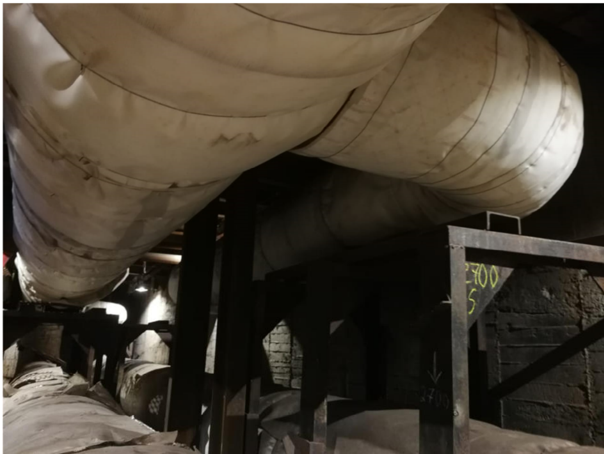
Мал. 2. Трубопровод Ø 700 мм
