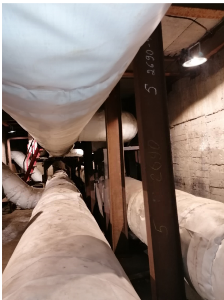
Мал. 2. Трубопровод Ø 700 мм
