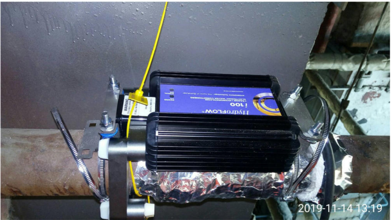
Мал. 3. Встановлений прилад HF I-100 в ТЦЦ на котлі ДКВР 20/13
