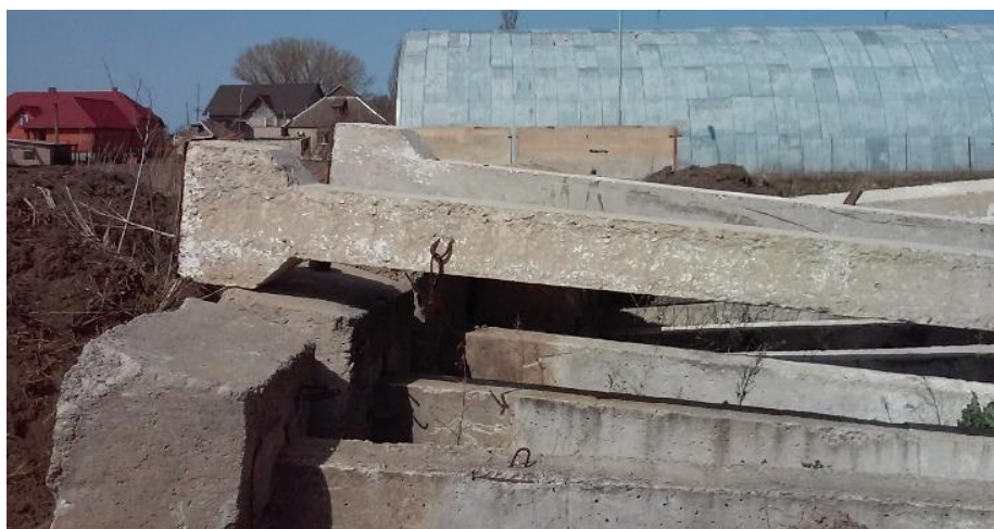
Фото 2. Залізобетонна двоконсольна колонна з фундаментом
