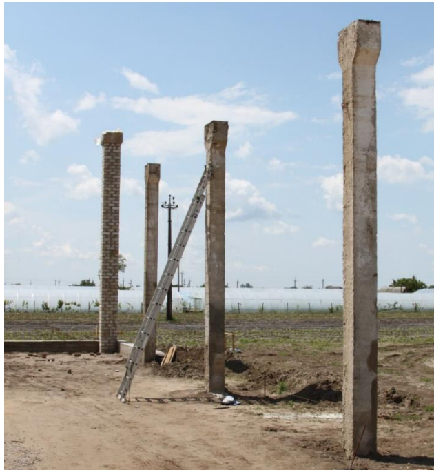
Фото 3. Загальний вигляд збірних залізобетонних колон №1-3
