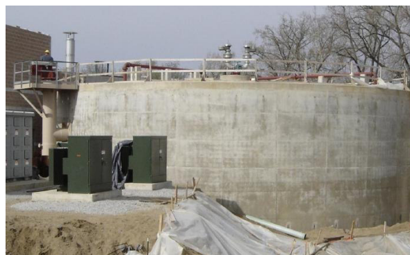
Рис. 2. Система гідравлічного перемішування з зовнішньої трубою
