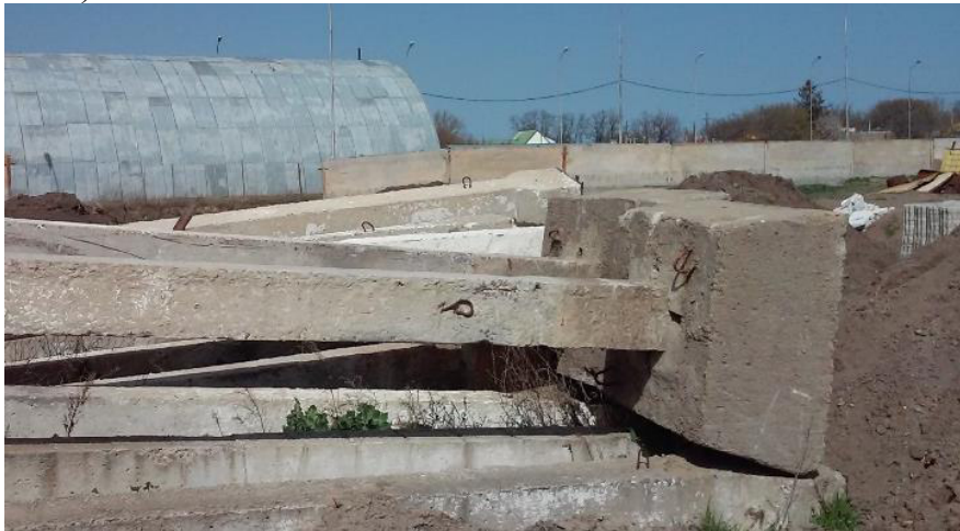
Фото 1. Загальний вигляд фундаменту
