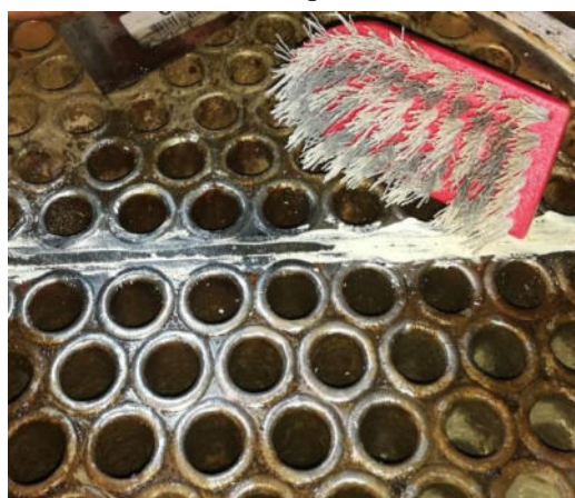
Рис.41. Очистка трубной доски с помощью бытовой пластиковой щетки
