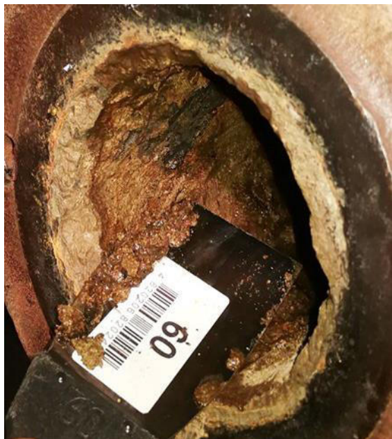
Рис.15. Снятие отложений с помощью металлического шпателя (труба подвода техводы перед ОБЪЕКТОМ«0»)
