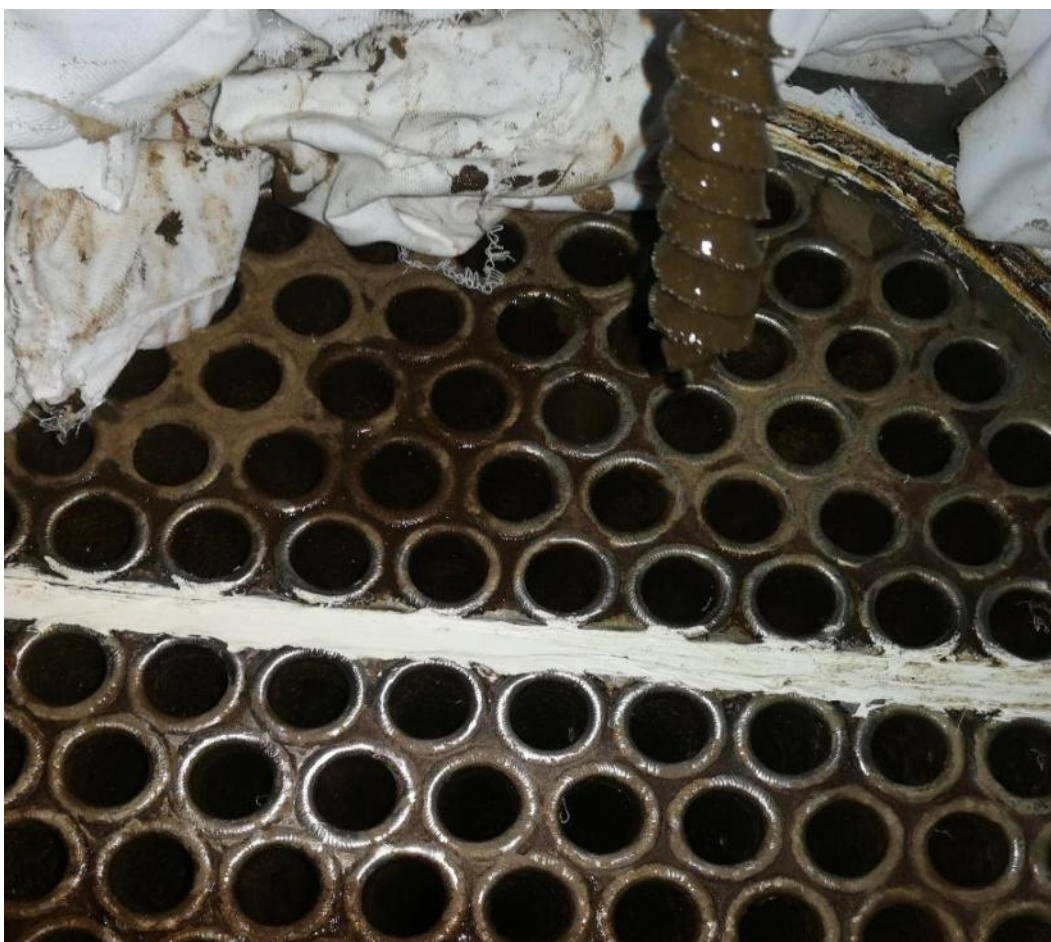
Рис.47. Очистка ТОТ с помощью металлического ерша
