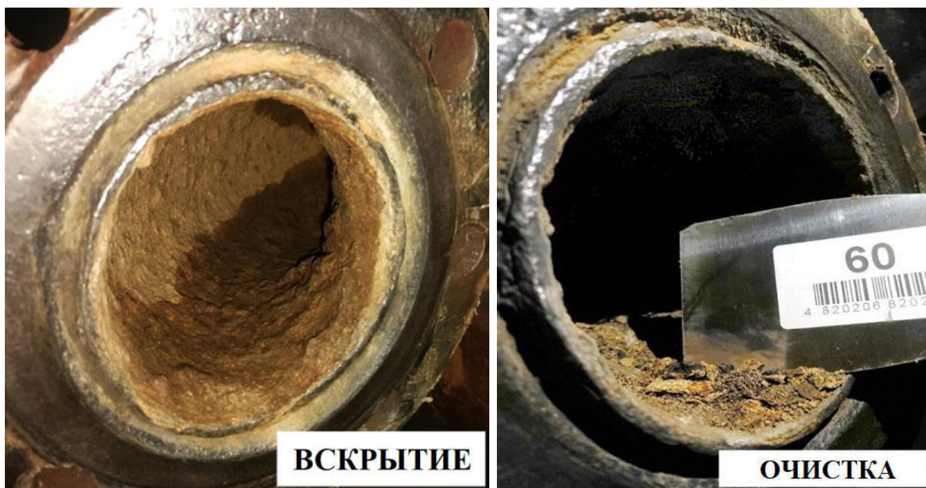
Рис.14. Очистка внутренней поверхности трубы отвода техводы ОБЪЕКТА«+» от отложений металлическим шпателем
