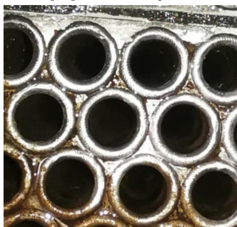
Рис.42. Очищенные, с помощью пластиковой щетки, «маяки» на трубной доске ОБЪЕКТА «+»
