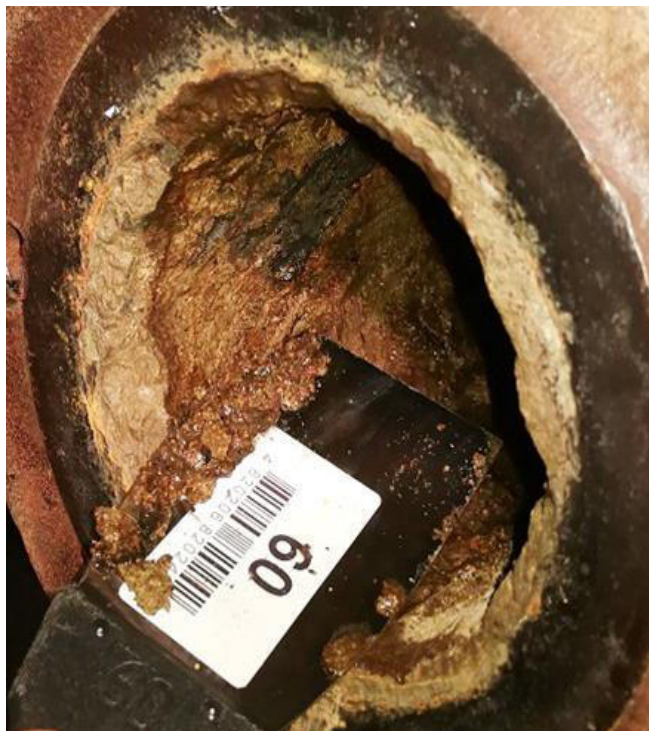
Мал.13 Зняття відкладень за допомогою металевого шпателя (труба підводу техводи перед ОБ'ЄКТОМ”0”)
