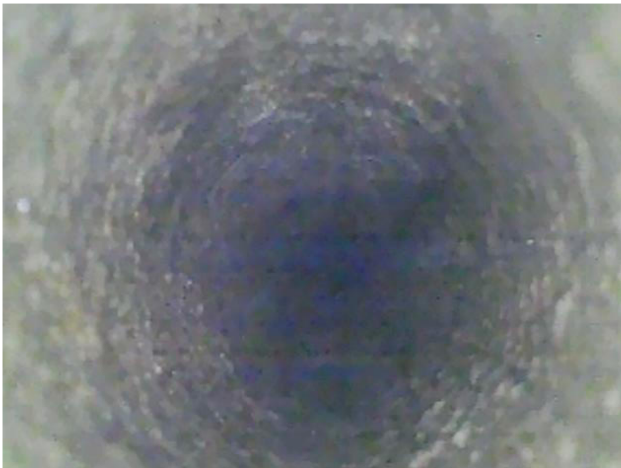
Мал.43 Фінальний стан нечищеної раніше ТОТ після очищення пластиком йоржем
