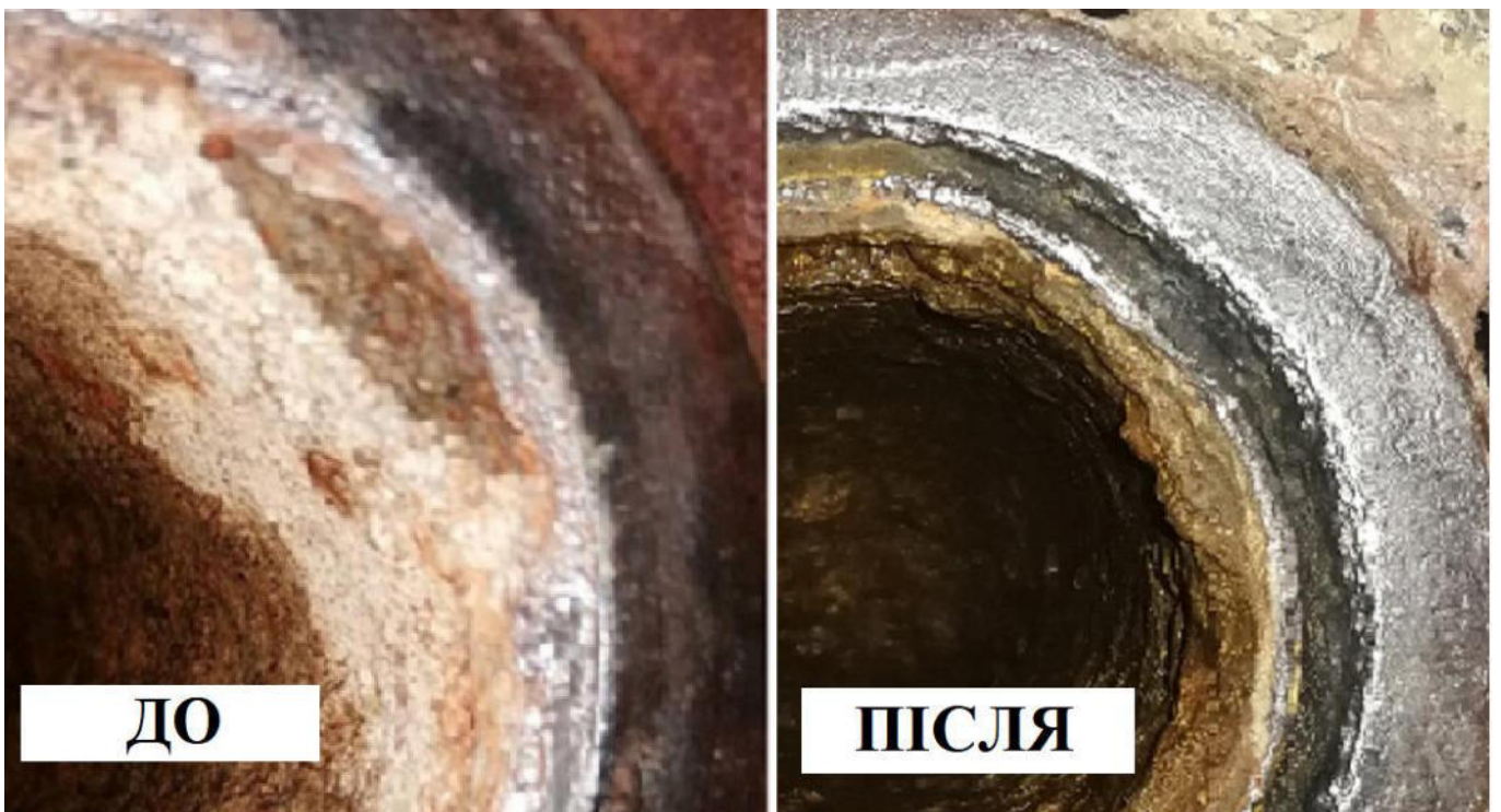
Мал.9 Збільшений фрагмент порівняння стану внутрішньої поверхні труби підводу техводи ОБ'ЄКТУ"+ на старті та у ході фінального розкриття
