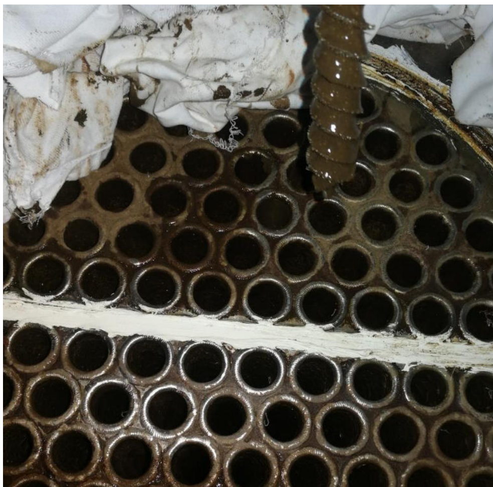
Мал.45 Очищення ТОВ за допомогою металевого йоржу
