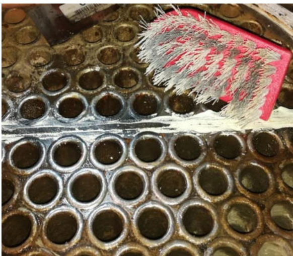
Мал.39 Очищення трубної дошки за допомогою побутової пластикової щітки
