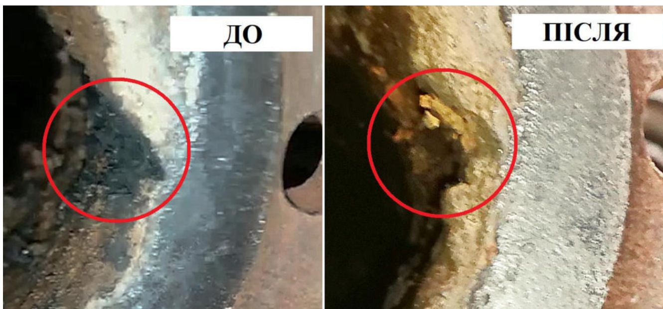
Мал.15 Порівняння стану внутрішніх поверхонь контрольної зарубки на трубі подачі техводи перед ОБ'ЄКТОМ«0» (Елемент «А») на початку випробувань та під час фінального розкриття (збільшене зображення)
