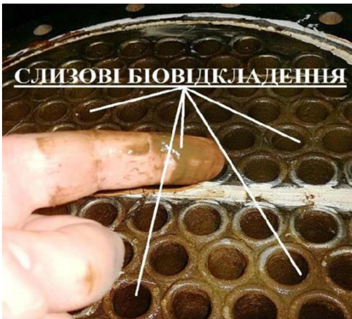
Мал.33 Слизові біовідкладення на трубній дошці ОБ'ЄКТУ«+» на початку випробувань
