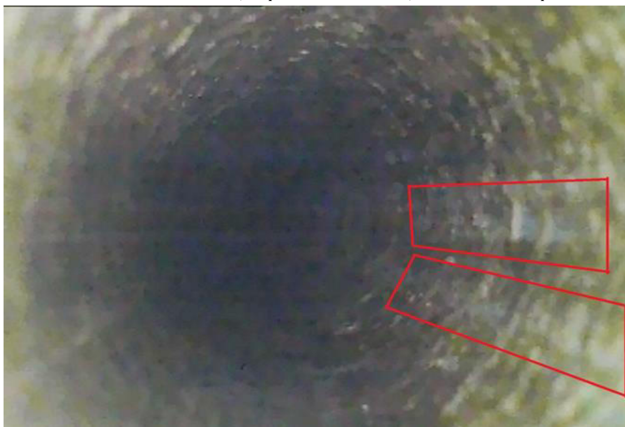
Мал.44 Стан ТОТ ОБ'ЄКТУ"+", раніше очищеної при проміжному розкритті 25.02.2020 р. за допомогою металевого йоржу
