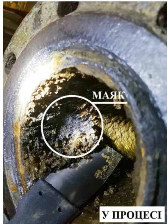
Мал.10 Очищення внутрішньої поверхні труби відводу техводи ОБ'ЄКТУ"«+» від відкладень металевим шпателем під час проміжного розкриття . У позиції «на 9 годин» шпателем, без особливих зусиль, зроблено додатковий маяк
