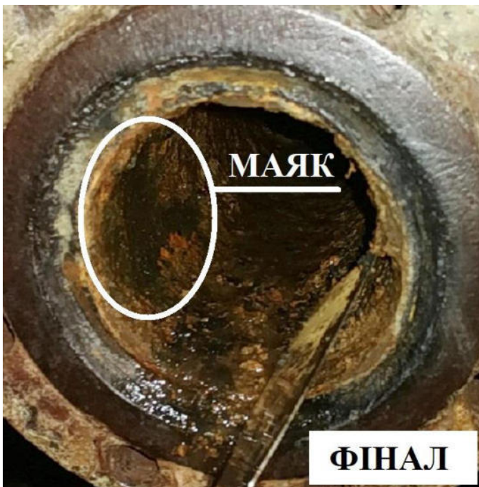
Мал.11. Очищення внутрішньої поверхні труби відводу техводи ОБ'ЄКТУ"«+» від залишкових відкладень металевим шпателем. Зроблений раніше маяк збільшився по площі без заростання по товщині
