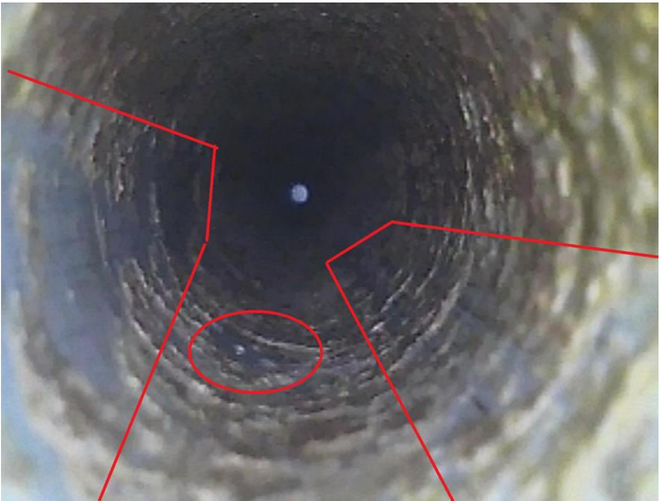
Мал.46 Зняття карбонатного шару зі стінки TOT з застосуванням металевого йоржу
