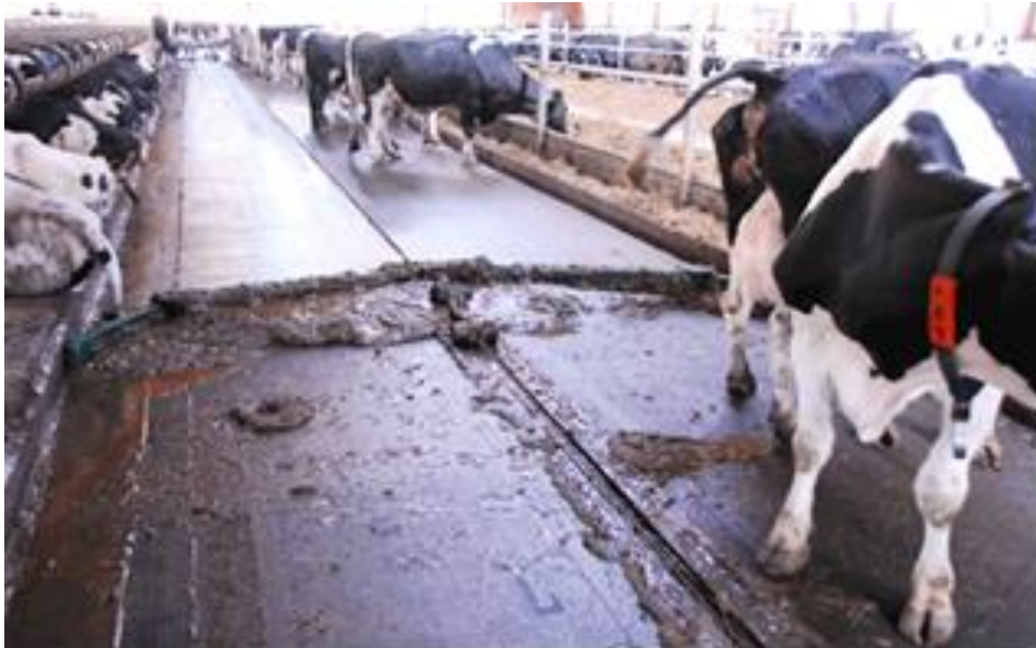
Рис. 1. Гладка бетонна поверхня гнойового каналу
